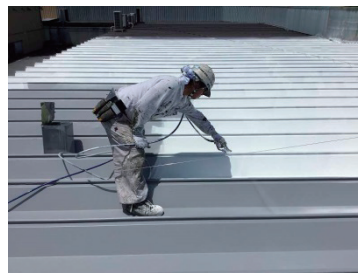
飛散が少ないスプレー施工で 工期短縮
