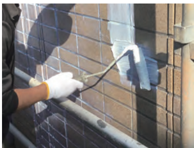
ローラーによる塗布
