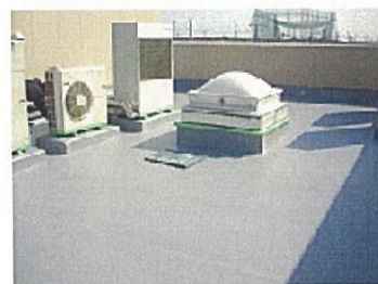
⑥防水工事完了
