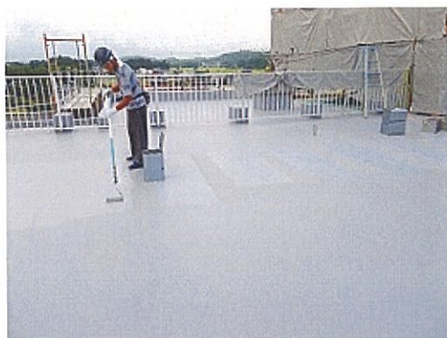
アクリルゴム系屋根用遮熱塗膜防水工法 「アトムレイス サーモJS工法」
