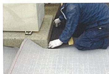
③緩衝シート張り付け状況
