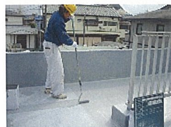
⑤防水材(アトムレイズ JS)の塗布状況
