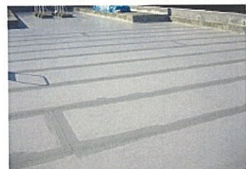
④緩衝シート張り完了
