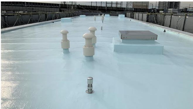
◆陸屋根（露出アスファルト下地）
